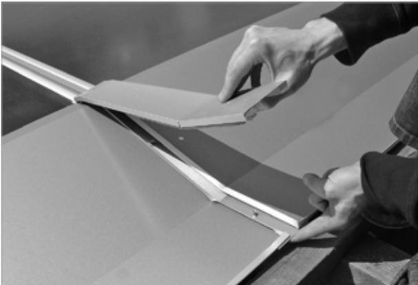
Fig. 82: coincidenza della lamiera superiore del connettore con la lamiera inferiore della copertura
