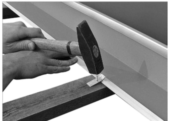
Fig. 59: fissaggio della lamiera ai correntini del tetto con chiodi e linguette
