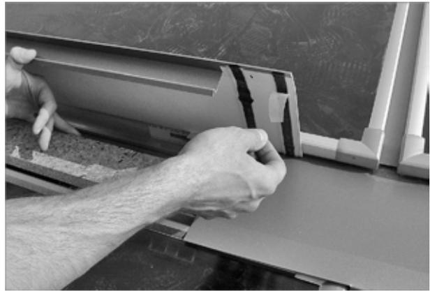
Fig. 75: montare ulteriori lamiere: prima dell'applicazione rimuovere la striscia di protezione
