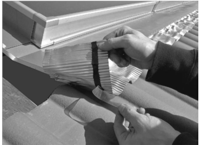
Fig. 49: rimuovere le strisce di protezione e premere i grempiuli
