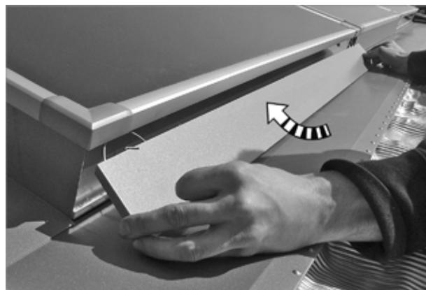
Fig. 90: applicare le lamiere di copertura lunghe davanti al lato frontale dei collettori
