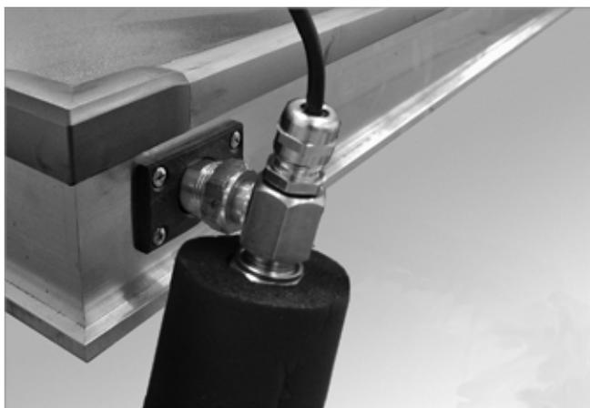
Fig. 92: Montaggio del sensore (mandata solare)
