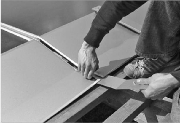
Fig. 81: spingere la lamiera inferiore del connettore sotto la lamiera superiore
