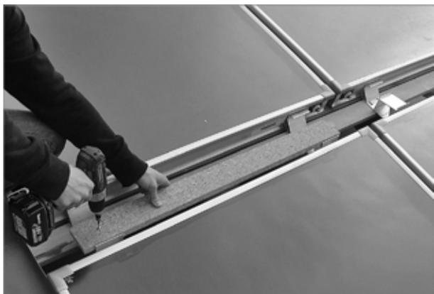
Fig. 68: avvitamento dei sostegni per le lamiera intermedie sui distanziali dei collettori
