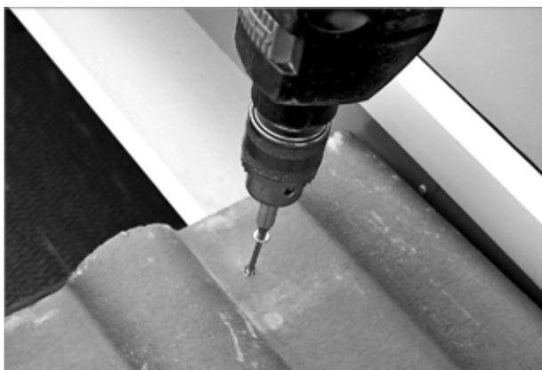
Fig. 88: fissare le tegole accanto alla lamiera laterale
