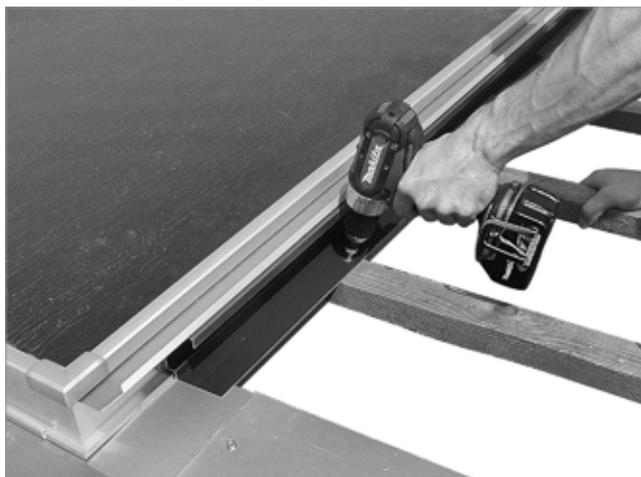
Fig. 53: spingerla verso il basso contro la battuta e avvitarla con i correntini del tetto
