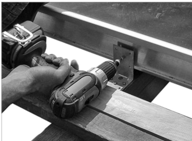
Fig. 51: nella parte frontale superiore, fissare il collettore al falso puntone
