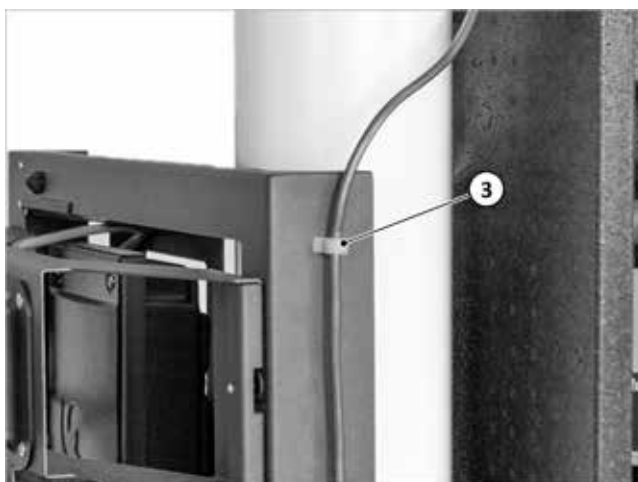
Fig. 79: Fissaggio della tubazione di alimentazione del gasolio al telaio
