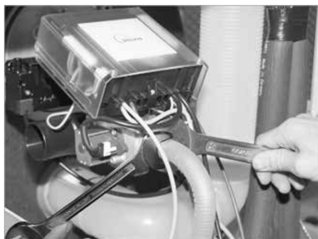
Fig. 60: collegamento della condotta del gas
