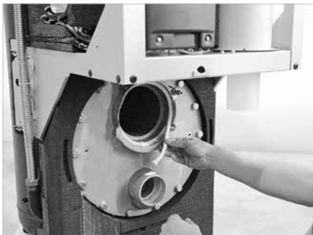
Fig. 46: Inserire il cordoncino di tenuta del bruciatore
