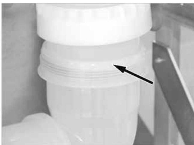
Fig. 65: avvitare e allineare la curva della tubazione fumi
