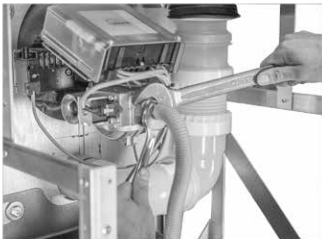
Fig. 46: collegamento della condotta del gas
