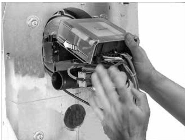
Fig. 31: Montaggio del bruciatore
