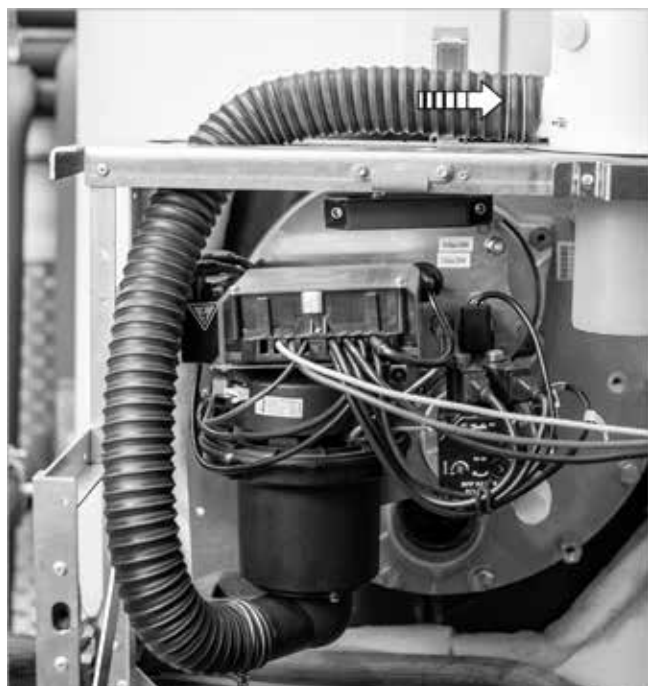
Fig. 59: Montaggio del tubo flessibile per l'aria di alimentazione
