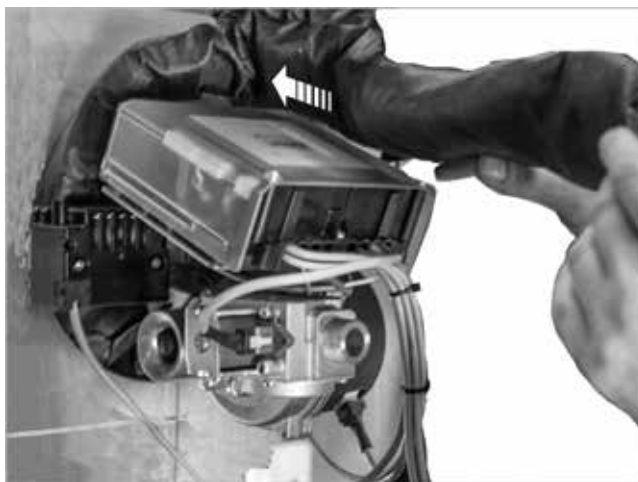
Fig. 32: Otturazione dell'incavo della flangia del bruciatore
