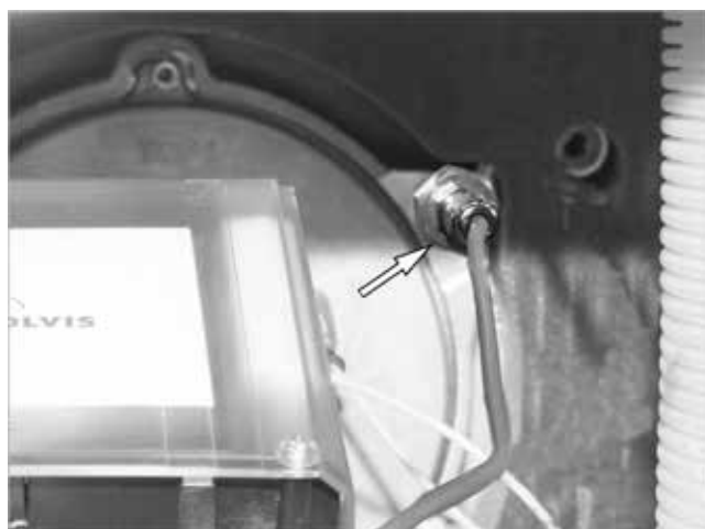
Fig. 112: inserimento dell'eSTB
