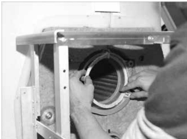
Fig. 52: posizionare il cordoncino di tenuta del bruciatore, a filo verso l'alto
