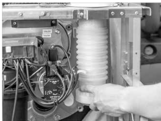
Fig. 63: Orientamento perpendicolarmente verso il basso del raccordo per lo scarico dei fumi
