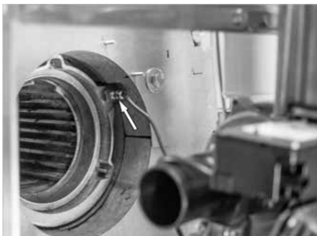
Fig. 30: inserimento dell'eSTB
