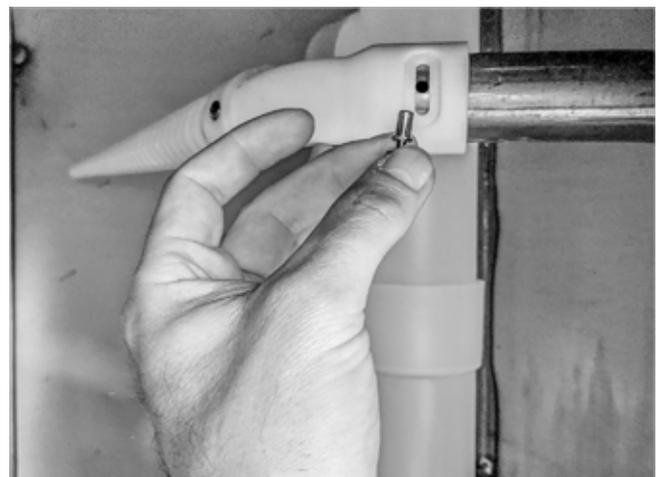
Fig.19: Fissaggio della lancia di carico con la rete
